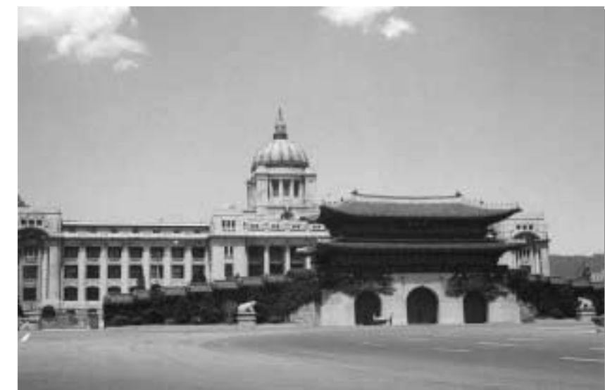
1960年代に再建したコンクリート造の光化門と旧総督府庁舎(前 国立中央博物館)
