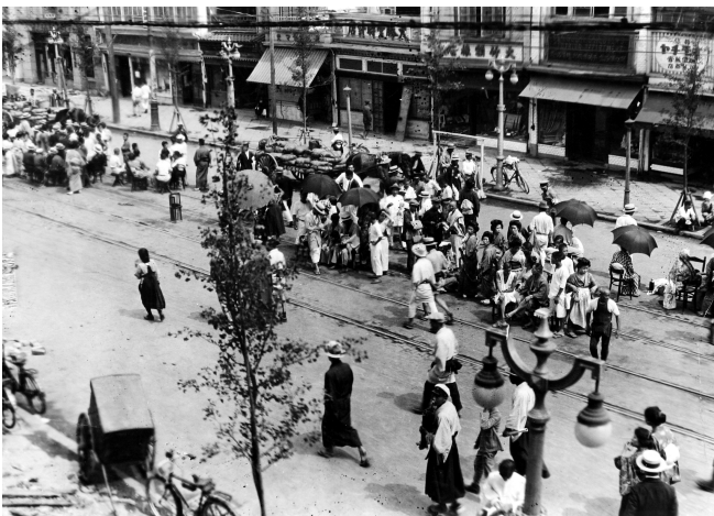
写真12 地震直後の銀座通り
