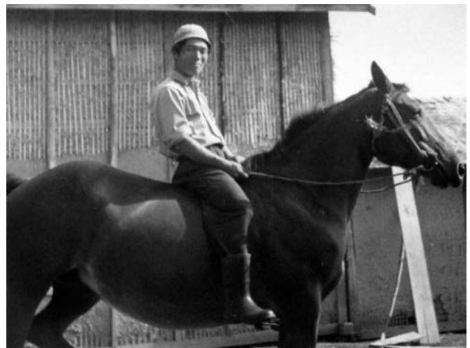
2-10-(1) 写っている馬はモベツである。勢いよく走る馬だった。背後の壁は、内側から土を塗って、木舞からその土がはみ出た状態である。これから、外側にも土を塗る。ただし、Yさんは、馬小屋の壁作りとして木舞の葺を結んだ覚えはないという。
