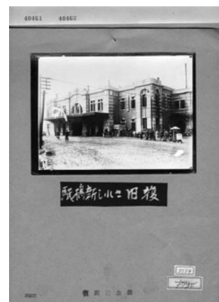
写真 8. 復旧された新橋駅
