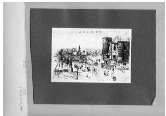
②-2. 万世橋駅付近
