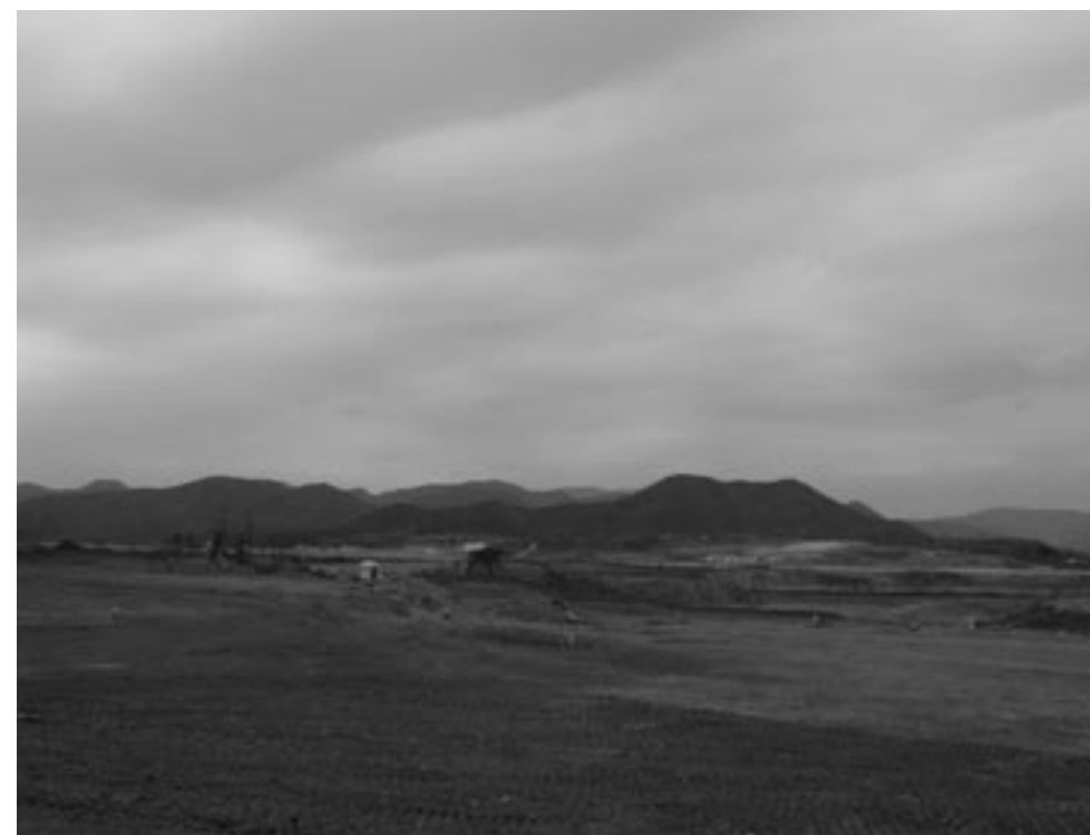
写真28 隠岐・新空港の建設現場
