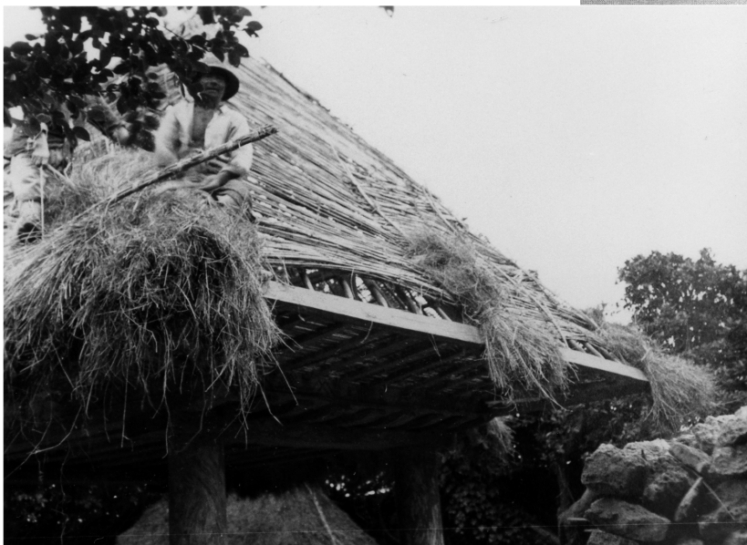
写真203 屋根葺 [目録番号: ア-6-7]
