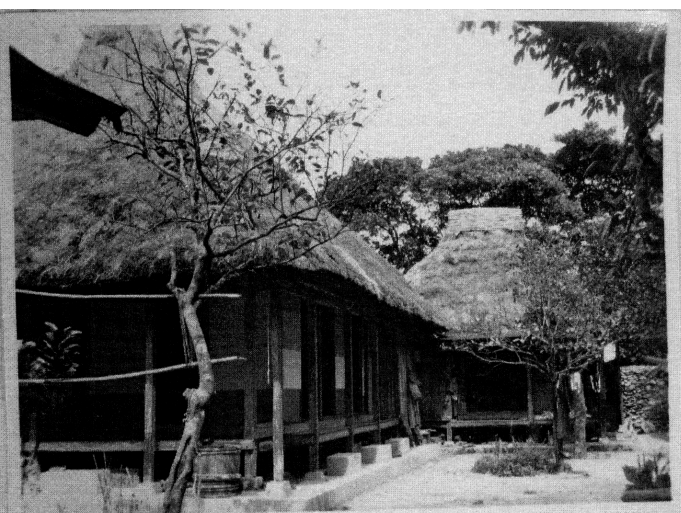
写真179 家屋（一丈三尺柱屋）昭11.3 阿伝 盛福成宅 [目録番号：写真類1-14-89]
