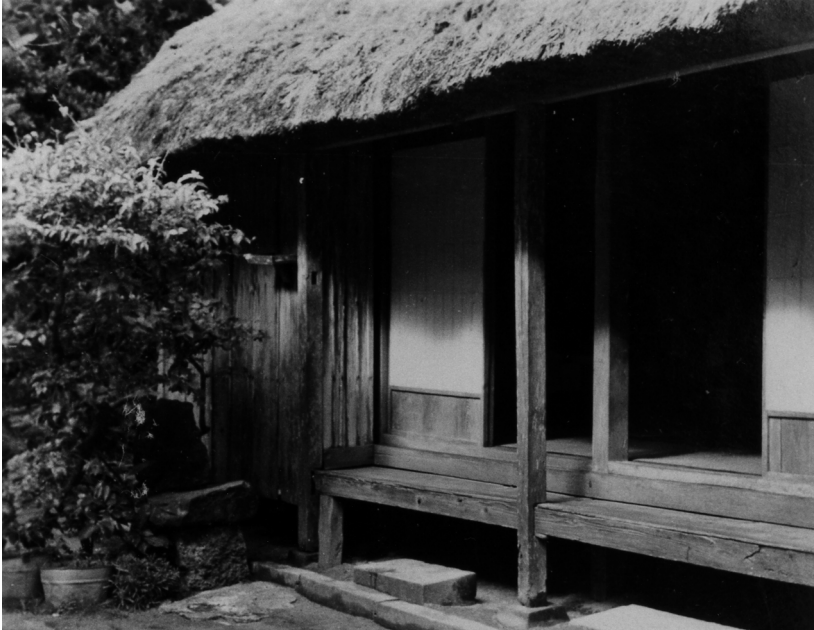
写真180 家屋A.一丈三尺柱（本柱ノ高さ） 表十畳敷ノ家（阿伝岩倉宅）ハンヤドゥ （hanjadu）〔目録番号：ア-6-12〕
