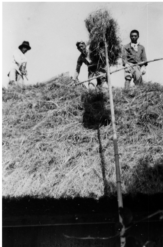
写真205 屋根葺 [目録番号：ア-6-5]
