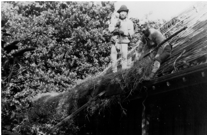
写真204 屋根葺 [目録番号：ア-6-4]
